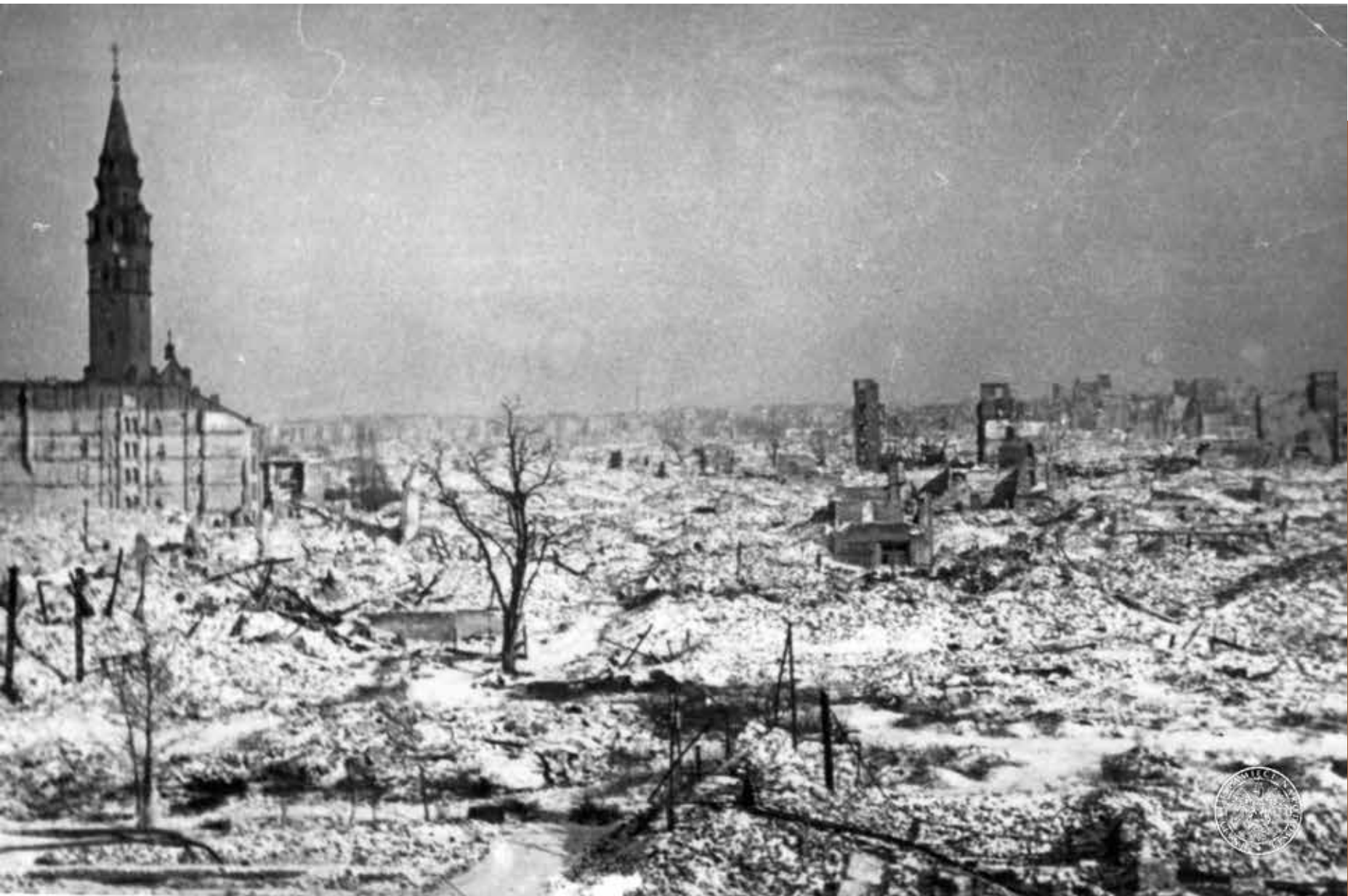
Kościół pw. Św. Augustyna (ul. Nowolipki 48/50) wśród ruin wyburzonej przez Niemców zabudowy byłego getta w rejonie skrzyżowania ulic Nowolipki i Smoczej oraz na południe od Nowolipki. (fot. autor nieustalony, AIPN, sygn. GK -13-2-1-58)
